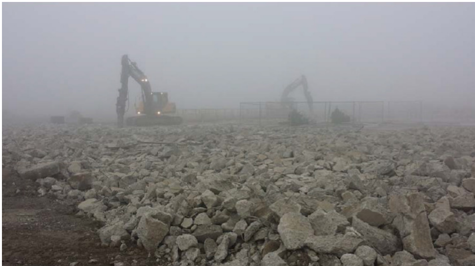
Figura 4: Demolizione opere in cemento con escavatori dotati di martello demolitore
