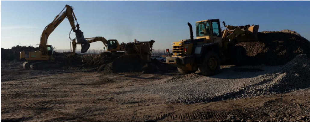
Figura 5: Riduzione volumetrica con impianto e carico con escavatore
